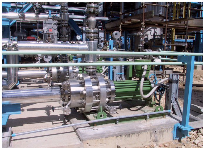
▲ Mit der doppelten Sicherheitshülle wird bei Spaltrohrmotorpumpen ein Höchstmaß an Dichtheit nach außen erreicht. Darüber hinaus haben sich diese Pumpen durch sehr lange Standzeiten und hohe MTBF-Werte als höchst zuverlässige Aggregate erwiesen.
