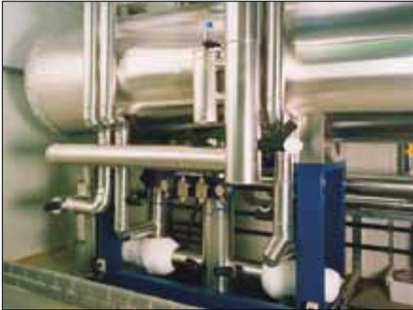
Vue d'une installation de froid à CO<sub>2</sub> avec pompe
