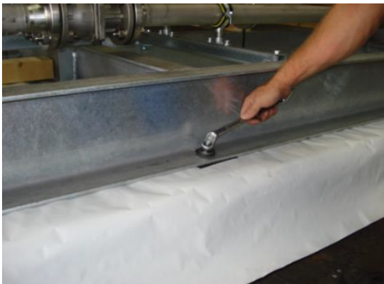
Verschrauben einer Pumpe / Screwing a pump
