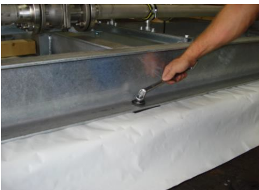
Verschrauben einer Pumpe / Screwing a pump
